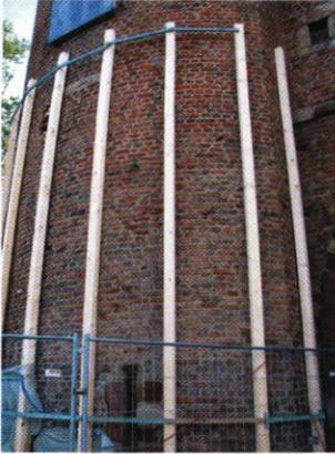
Abb.9: Sicherung während der Bauzeit
