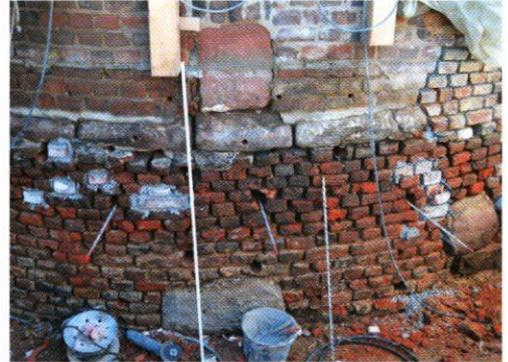
Abb. 4: Vernadelungen eines Fundamentwand-Abschnittes
