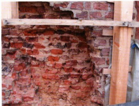
Abb.14 Ausgebrochener Mauerbereich
