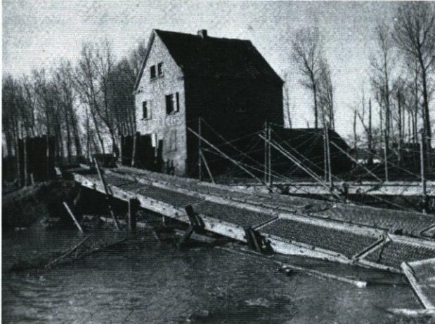
*Abb. 41: Eingestürzte Bailey Bridge über die Erft bei Glesch (Foto: US Army Photograph).*
