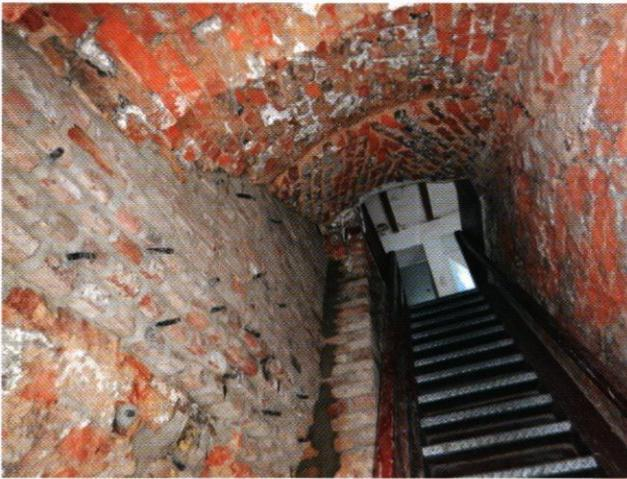
*Abb. 24: Freigelegter Treppenaufgang, seitliche Mauerwerkssanierung*
