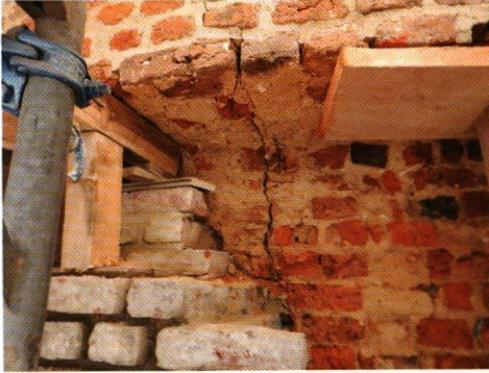
Abb. 12: Sanierung im Rissbereich
