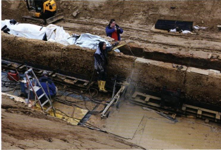
Abb. 8: Hürth-Hermülheim, Trennen einzelner Wasserleitungsteilstücke mittels Seilzugsäge. Bildurheber: Z. Görür, ArchaeoNet.
