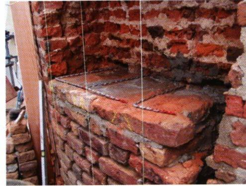
Abb.15: Neu aufgemauerter Abschnitt mit Mauerankern
