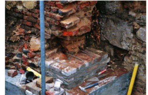
Abb. 6: Fundamentsanierung: Torbogen/Aachener Tor mit Sicherungen
