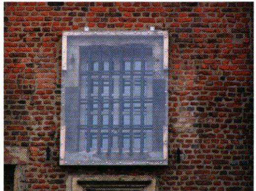
Abb. 2: Sicherung der Fenstergewände vor der Sanierung
