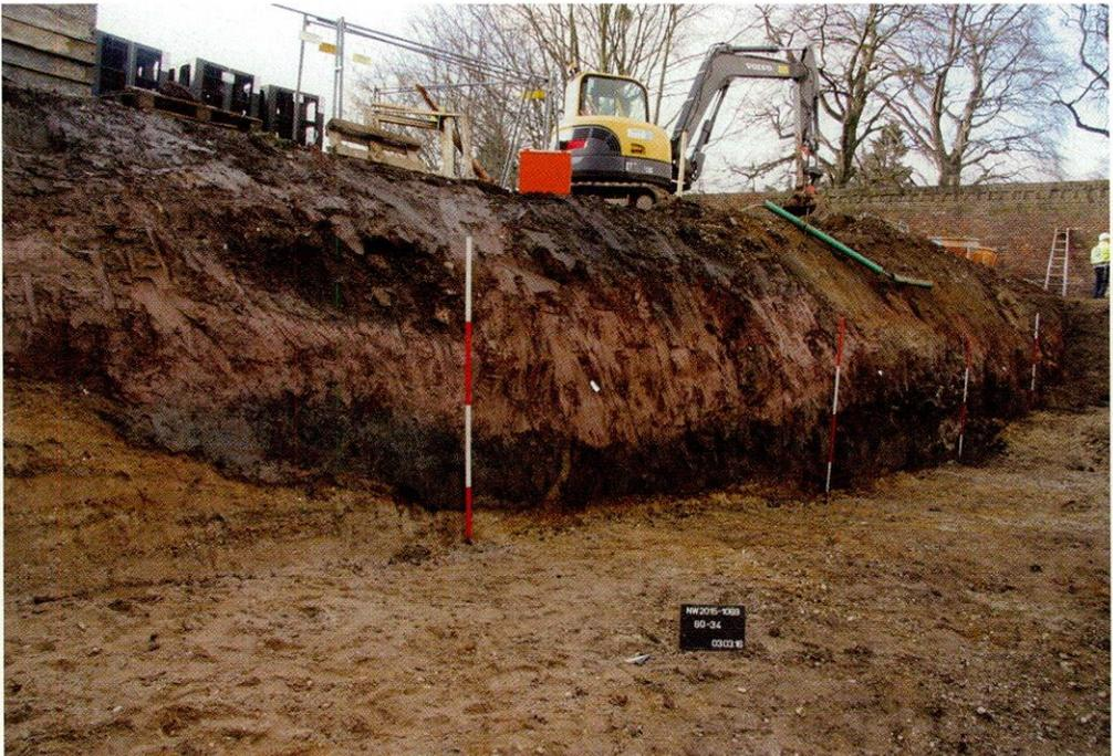
*Abb. 4: Das Westprofil der Baugrube für die Rigole von Südosten. Der Damm ist als graue Erhebung zwischen den mittleren Fluchtstangen zu erkennen.*
