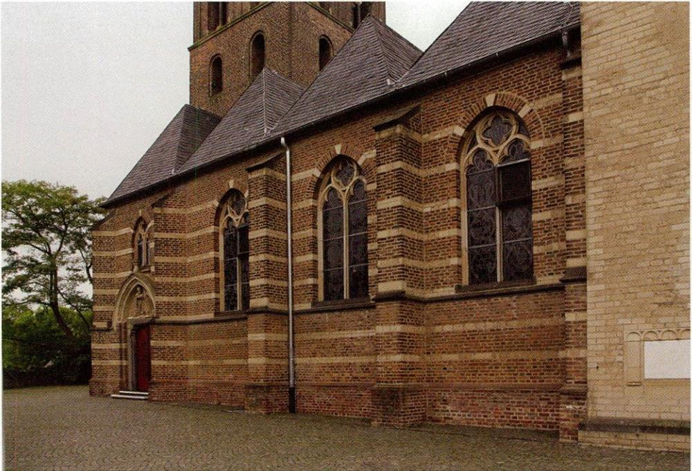
Abb. 16: Bergheim, St. Remigius. Südseite des spätgotischen Langhauses in Speklagen-Technik. Das westliche Joch mit dem Portal und die Fenstermaßwerke stammen aus dem späten 19. Jahrhundert (2015).
