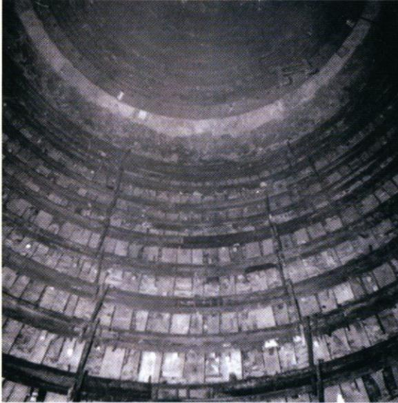
Abb. 2: Schacht 2: vorläufiger Ausbau, unten nachge-zogen bereits endgültiger Ausbau bis Teufe 296,3 m mit Hintergrund-Betonierung (Ralf Hempel, Rückbau und Überbaggerung der Tiefbaugrube Union 103 im Tagebau Hambach, o. O. 2011, S. 20).
