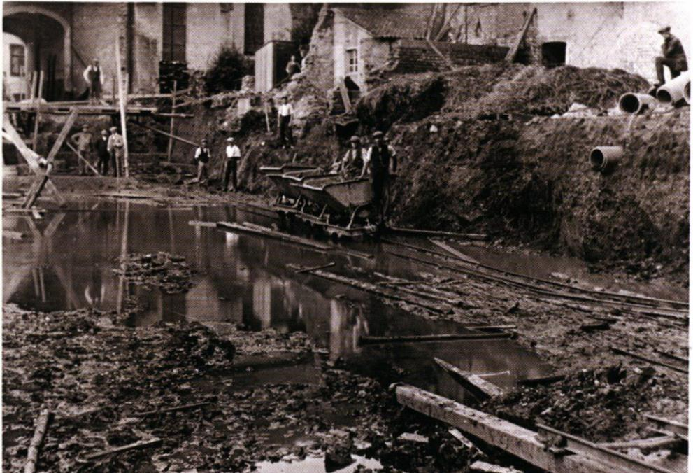
Abb. 5: Hochwasser in der Baugrube.
