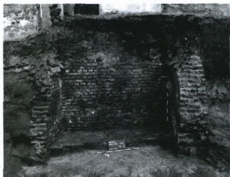
Abb. 12: Bergheim, Kentener Mühle. Kellerfundament
